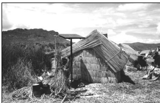
Fig. 3 – Isla y vivienda de los Uros construidas de totora y el generador fotovoltaico utilizado. [Foto: F. Morante]
