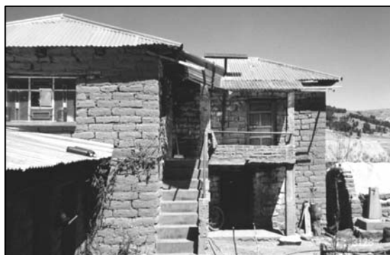
Fig. 9 – Vivienda y generador fotovoltaico de Huancho Lima. [Foto: F. Morante]
